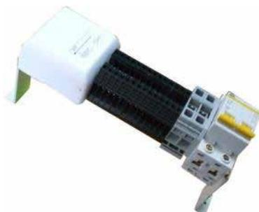
Предназначен для удобного подключения цепей питания и управления дополнительного оборудования (датчиков, видеокамер и т.д.). Кроме того, возможно подключение двух устройств с высокой нагрузкой до 10А каждый, например, прожекторов.
